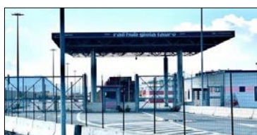
CORAP TRASFERISCE A REGIONE PROPRIETÀ DEL RACCORDO FERROVIARIO
