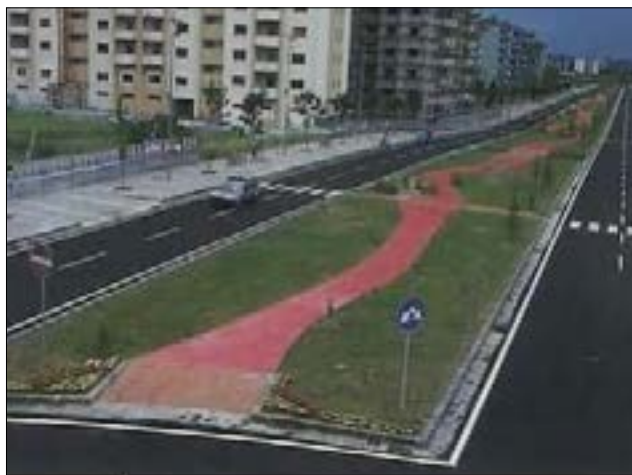
Com'era Viale Giacomo Mancini prima dei lavori; in alto in apertura lo stato attuale
