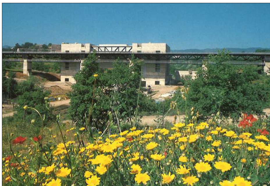
Le origini dell'Unical: il Dipartimento di Chimica in costruzione
