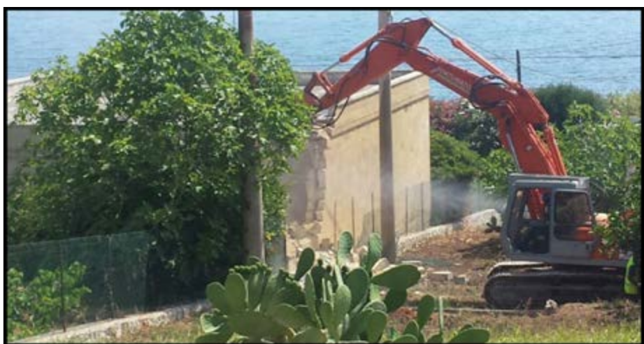
Figura 24 - Una ruspa demolisce una villetta vicino al mare.
