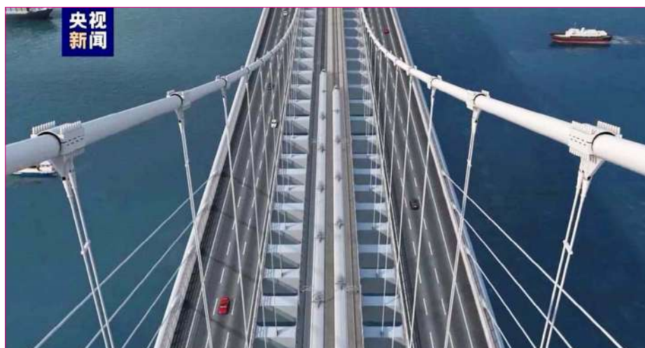
FIGURA 3-1 - XIHOUMEN HIGHWAY AND RAILWAY BRIDGE: DETTAGLIO DEL SISTEMA DI SOSPENSIONE
