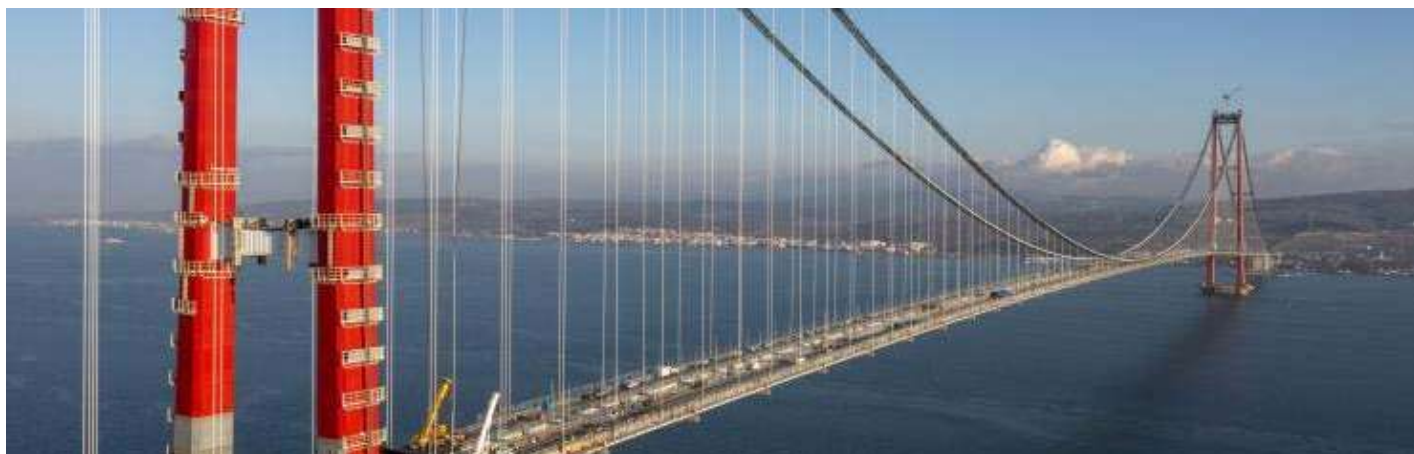
IL PONTE SULLO STRETTO DEI DARDANELLI "1915 ÇANAKKALE BRIDGE" COSTRUITO UTILIZZANDO IL PROGETTO "MESSINA TYPE" DELLO STRETTO
