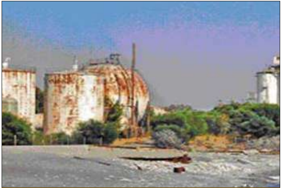
I RESTI DELLA LIQUICHIMICA DI SALINE JONICHE: MAI ENTRATA IN FUNZIONE
